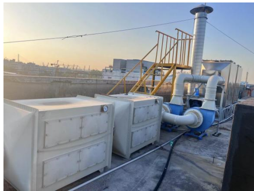
DA001 废气处理设施及排气筒、废气排口标牌
