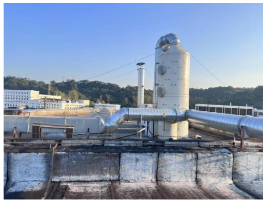
DA002、DA003 废气处理设施及排气筒、废气排口标牌
