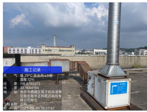
DA002、DA003 废气处理设施及排气筒、废气排口标牌
