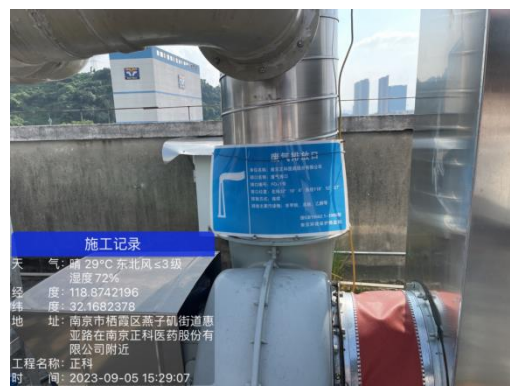
DA001 废气处理设施及排气筒、废气排口标牌
